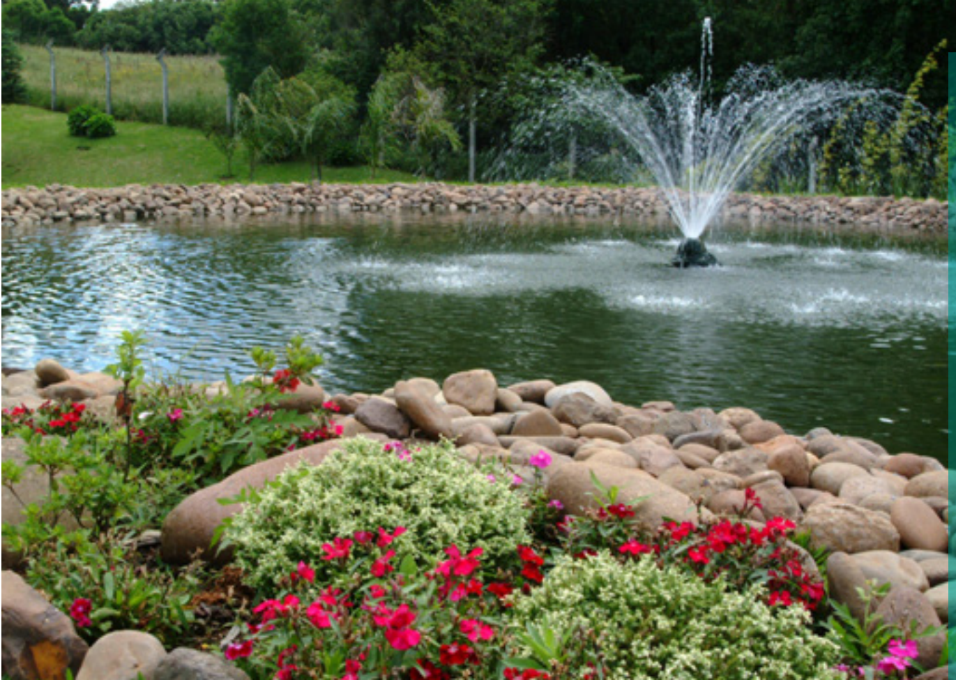
Estação de Tratamento de Efluentes - etapa de tratamento por lagoas
