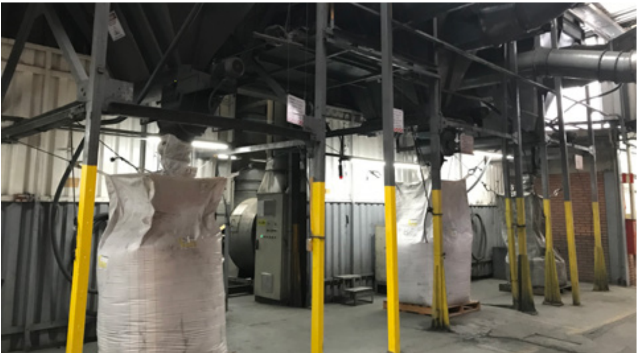
Sistema de Captação de Material Particulado
